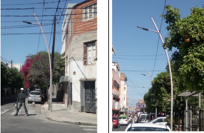
Figura 7: Calles: comercial (izquierda) y residencial (derecha) con idéntica luminaria y potencia. Fuente: imágenes del autor
