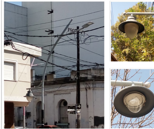
Figura 8: Luminaria instalada en avenida Roca, y artefactos de vereda de Roca (arriba), y de Av. Moreno (abajo).
